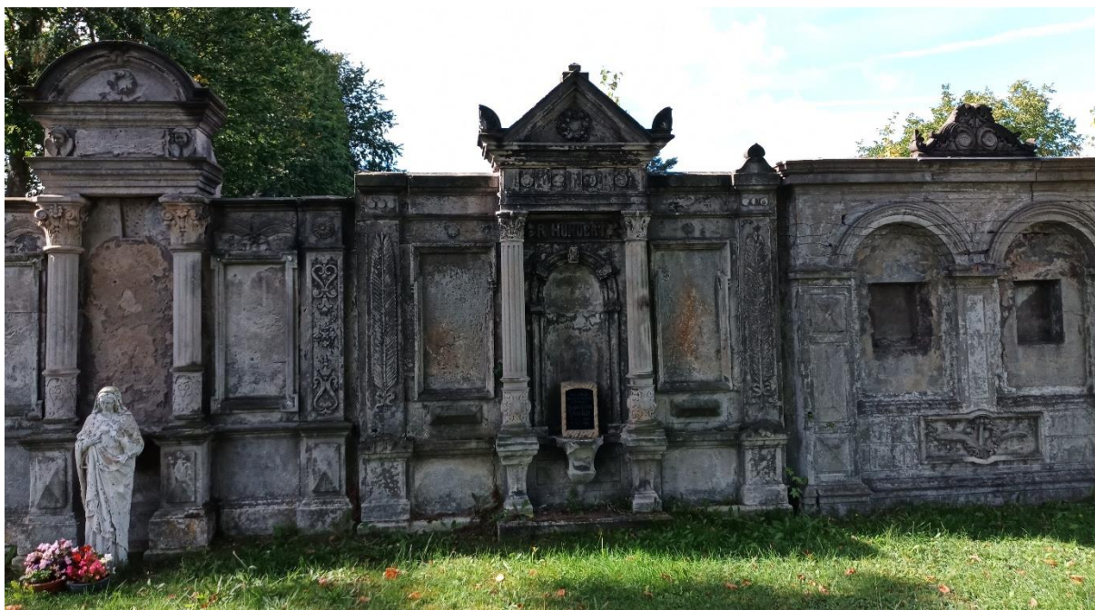
Ryc. 9. Fragment muru cmentarnego w Czerwonej Wodzie z nagrobkami przyściennymi. Fot. P. Zubrzycki.
