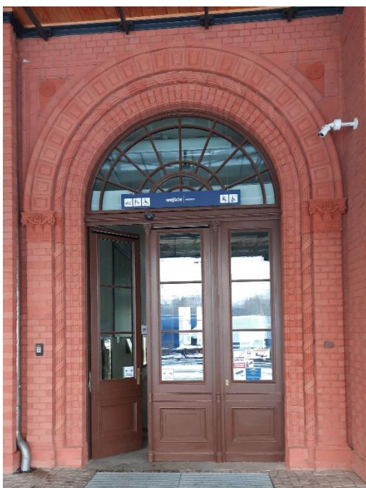
Ryc. 14. Młodszy dworzec (dworzec kolei drezdeńskiej) w Węglińcu, zbliżenie na jedno z wejść z peronu. Fot. P. Zubrzycki.
