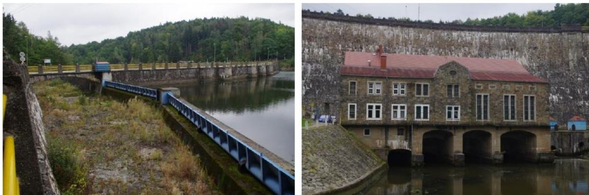
Rysunek 32. Widok na zaporę (od lewej) i budynek elektrowni (od prawej) na Jeziorze Złotnickim.
