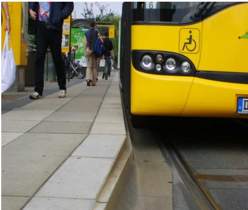
Rys. 8.3 Wyrównanie wysokości krawędzi peronowej z pierwszymi drzwiami autobusu Źródło: Materiały własne
