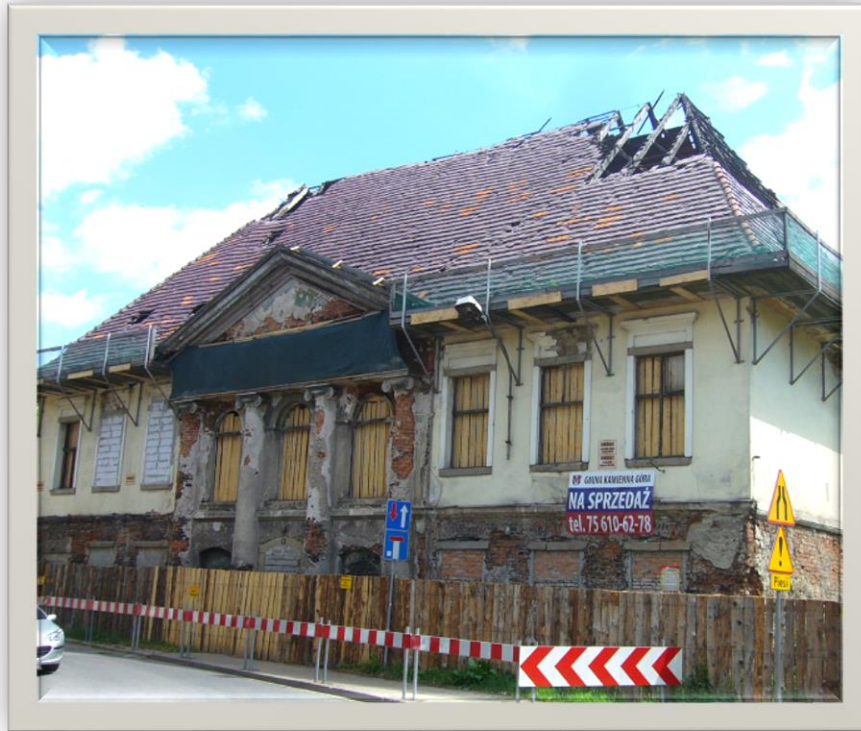
Foto 23. Budynek ul. S. Okrzei nr 14 – zdjęcie z 2020 r.
