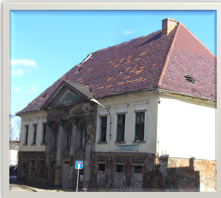
Foto 22. Budynek ul. S. Okrzei nr 14 – zdjęcie z 2014 r.
